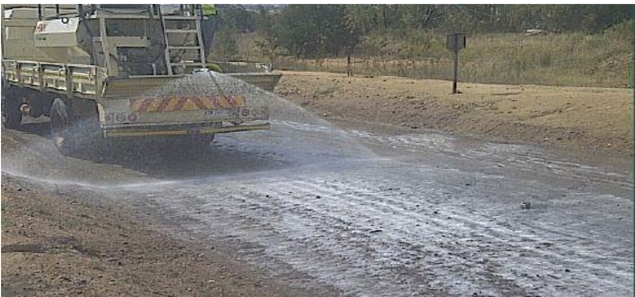
Figura 5 - Applicazione su suolo di LA-PAM in forma solubile con autobotte a ugello largo
