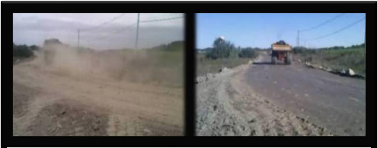
Figura 4 - DIMINUIZIONE POLVEROSITA' - visibile l'effetto di LA-PAM prima e dopo la sua applicazione in strade non battute
