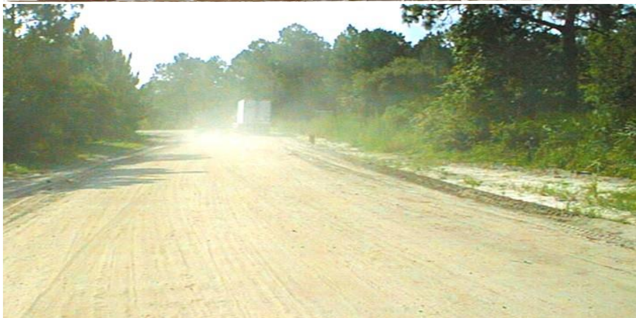
Figura 6 - Sensibile diminuzione della polverosità al passaggio di veicoli conseguente all'applicazione di LA-PAM
